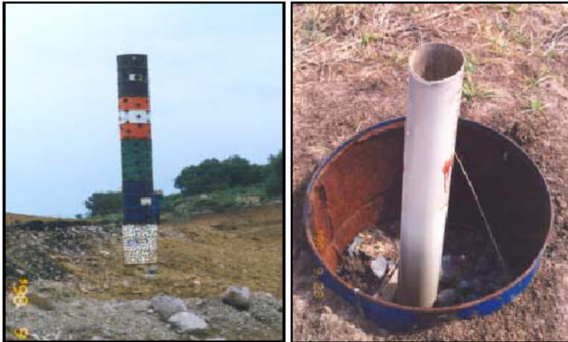
Figura 12. Sistema simple de captación de biogás
